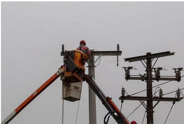
e aumentar a capacidade de distribuição. A rede definitiva será compacta, utilizando condutores cobertos e separadores losangulares, substituindo o modelo convencional de rede nua. A capacidade da rede trifásica também será ampliada de 6 MVA para 14 MVA, garantindo um fornecimento de energia mais robusto e confiável para os municípios de Ijuí, Bozano, Augusto Pestana, Jóia e Coronel Barros.
